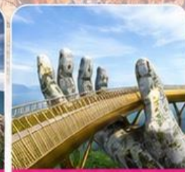
สะพานมือสีทอง
